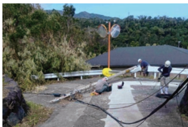
電柱の復旧作業
