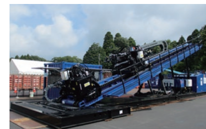
弧状推進工法(アースシャトル工法)
