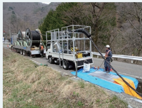
地下ケーブルの延線・接続作業
