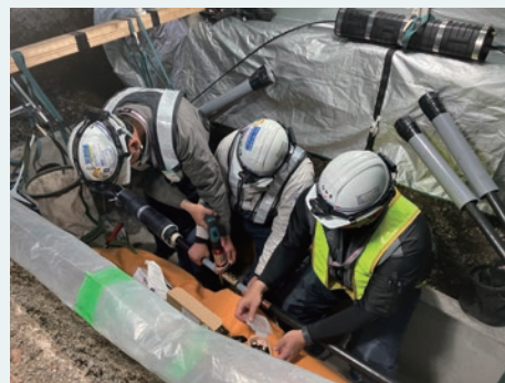
特別高圧ケーブルの接続作業
