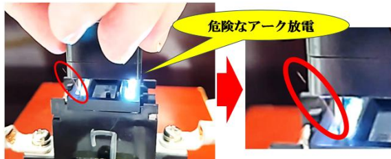
活線挿抜実験の様子
