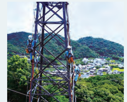
地上100メートルの鉄塔での架空送電線構築作業の様子
