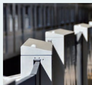
鉄道通信工事
