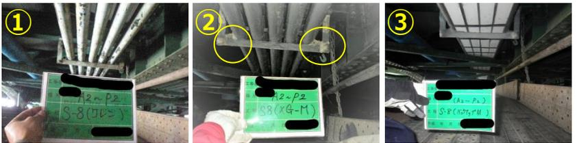
【施工前】 【充填剤塗布】 【バックアップ材設置】
