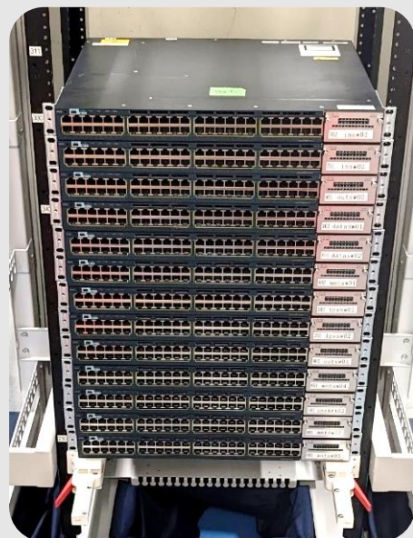
約100kgの装置重量を支持(4か所取付)
