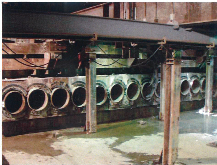
●9号京都西立体千代原トンネル本体工事 使用工法：パイプルーフ工法、アンクルモールシャトル工法、他
