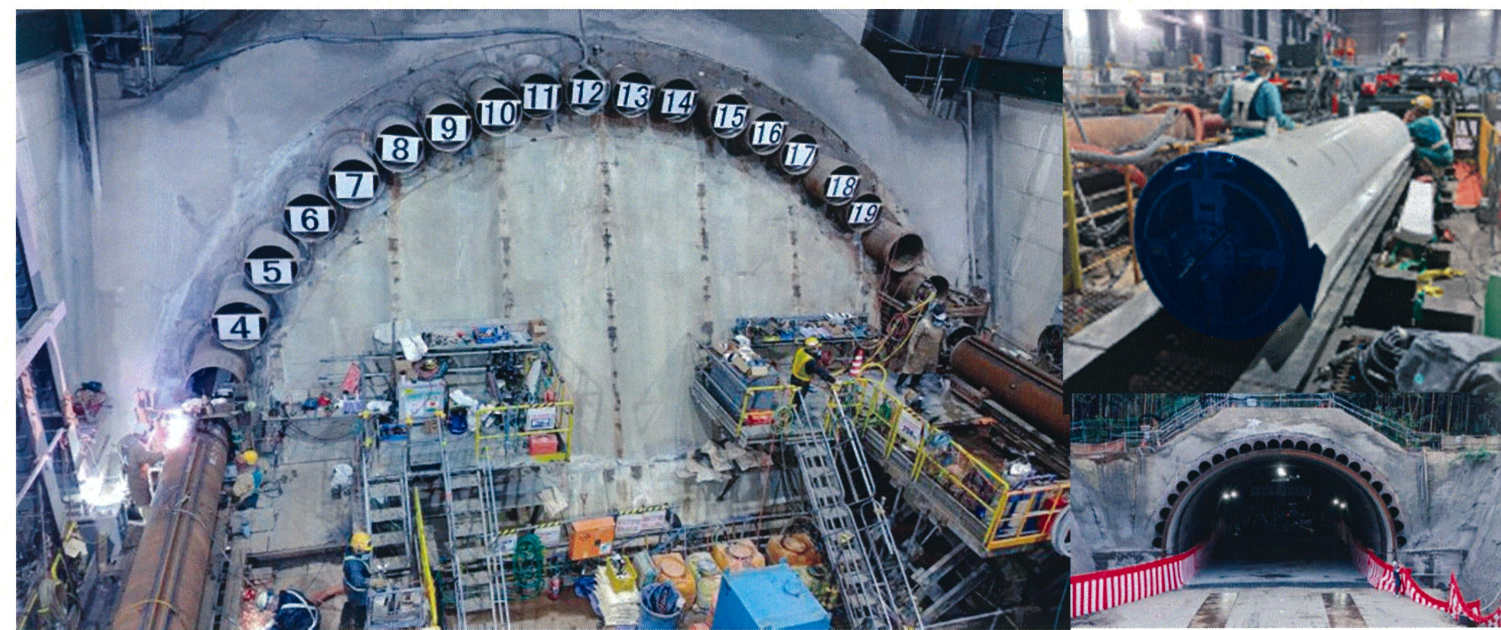
●台東区蔵前二丁目・浅草橋三丁目付近再構築工事 使用工法：アンクルモール工法（急勾配推進）
