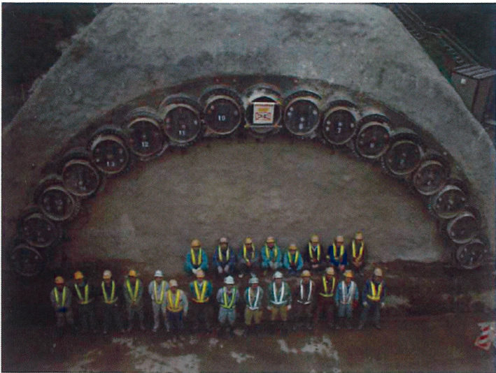
●東北新幹線、市川トンネル他1工事 使用工法：パイプルーフ工法、アンクルモールシャトル工法他
