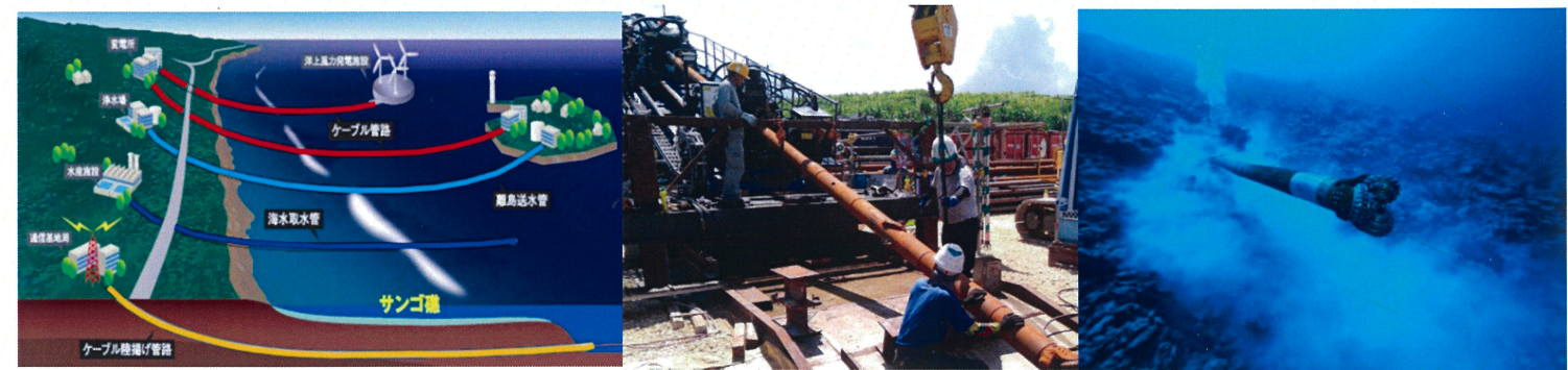
●沖縄県 南北大東島ケーブル敷設工事 使用工法：アースシャトル工法
