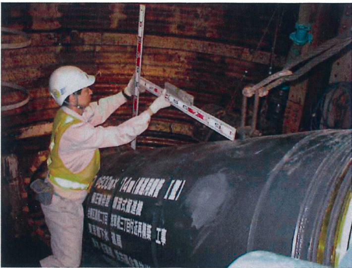
●台東区蔵前二丁目・浅草橋三丁目付近再構築工事 使用工法：アンクルモール工法（急勾配推進）
