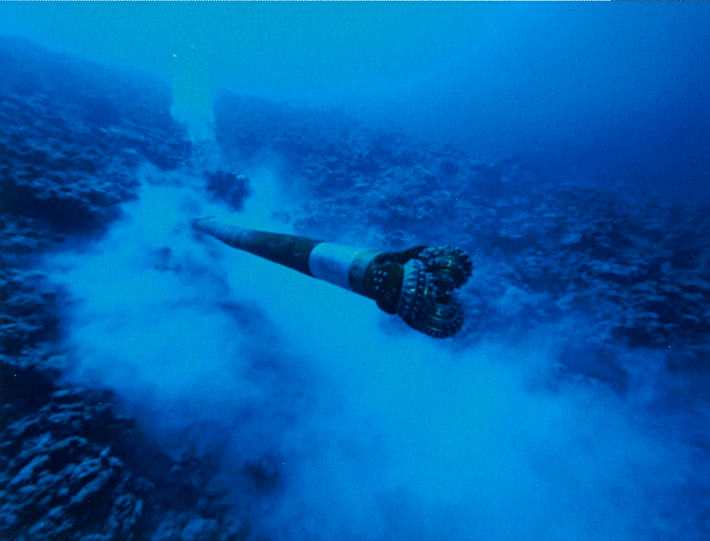
●沖縄県 南北大東島ケーブル敷設工事 使用工法：アースシャトル工法
