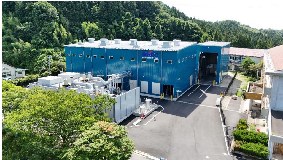
【ふるどの論田エコパワー発電所全景】
