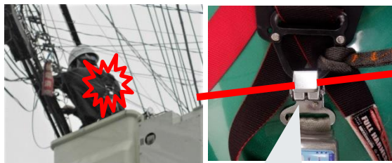
フックの部分にドロップケーブルが引っ掛かる
