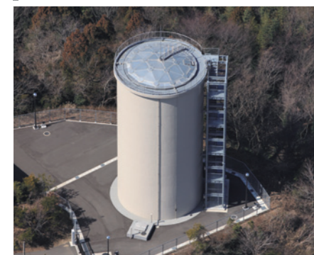
愛知県豊橋市 北部配水塔 Northern water tower, Toyohashi City, Aichi
