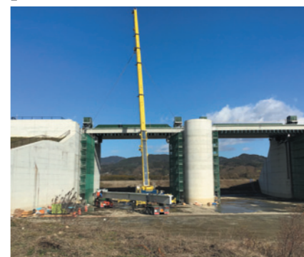
岩手県一関市 大林水門管理橋 Obayashi Floodgate Inspection Bridge in Ichinoseki City, Iwate
