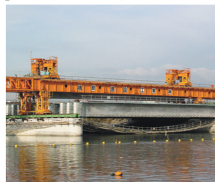
福岡県福岡市 御島かたらい橋 Mishima Katarai Bridge, Fukuoka City, Fukuoka
