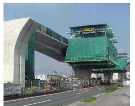
香川県高松市 伏石高架橋 Fuseishi Elevated Bridge, Takamatsu City, Kagawa
