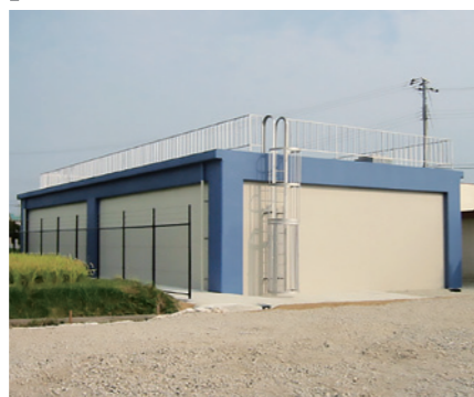
兵庫県三木市 広野配水場 Hirono water distribution field, Miki City, Hyogo
