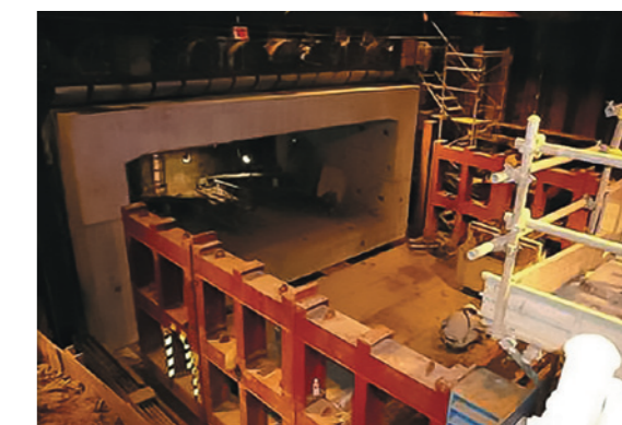
ボックスカルバート推進の様子 Box Culvert Jacking
