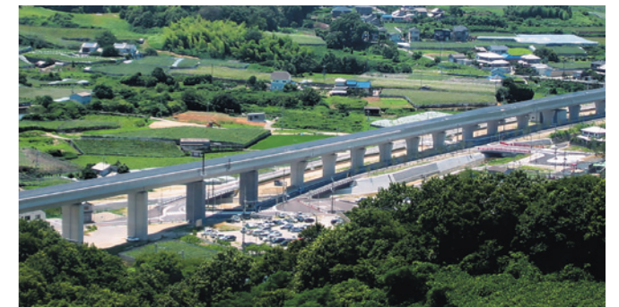
大阪府羽曳野市 飛鳥高架橋 Asuka Elevated Bridge, Habikino City, Osaka
