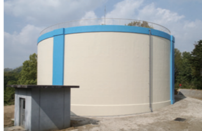
奈良県御所市 秋津配水池 Akitsu water tank, Gose City, Nara
