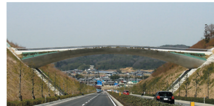
兵庫県三木市 三木総合防災公園5号橋 Bridge No.5 at Miki Sogo Bosai Park, Miki City, Hyogo
