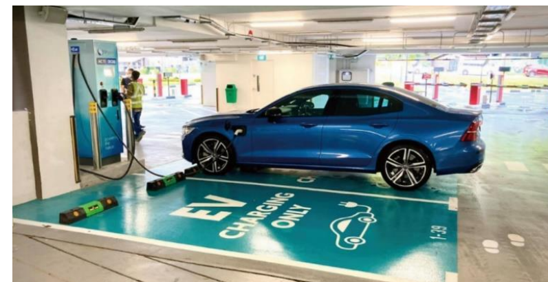
シンガポールのEVチャージャ設置工事
