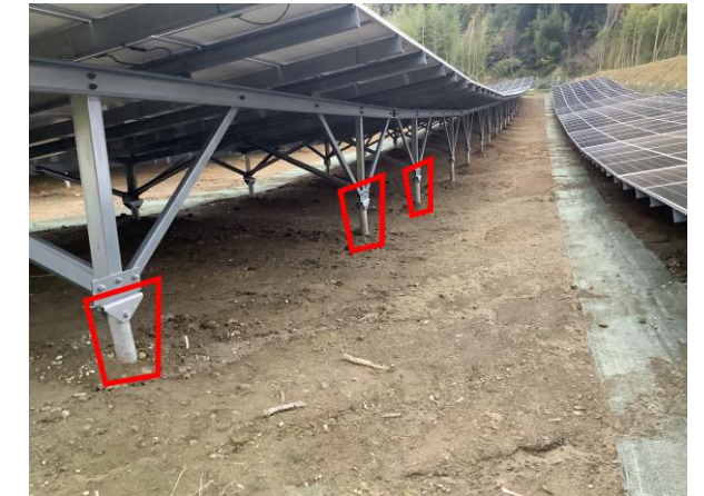
3Dモデルに沿ってミリ単位で施工
