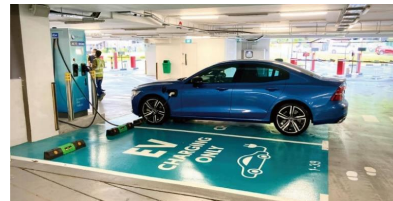
シンガポールのEVチャージャ設置工事 (合計 314サイト、987台のEVチャージャーを設置)
