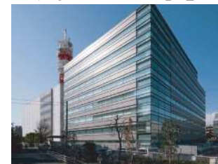
【電気・空調工事】
