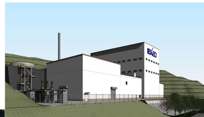
△ 栃木県バイオマス発電所 (イメージ) 発電規模: 7,000kw (売電6,000kw) 燃料: 国産自然木由来木質バイオマス 売電開始時期: 2023年中
