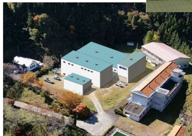
◇ 福島県バイオマスガス化発電所 (イメージ) 発電規模: 2,000kw (売電1,800kw) 燃料: 木質チップの乾留で発生する可燃性ガス 売電開始時期: 2024年中
