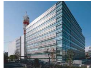
【電気・空調工事】
