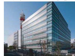
【電気・空調工事】
