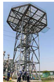
屋外・屋内の無線 基地局工事
