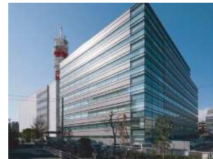
【電気・空調工事】
