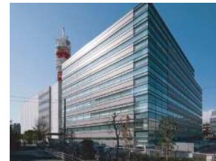
【電気・空調工事】
