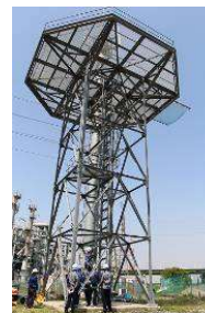
屋外・屋内の無線基地局工事
