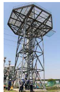
屋外・屋内の無線 基地局工事
