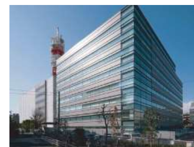
【電気・空調工事】
