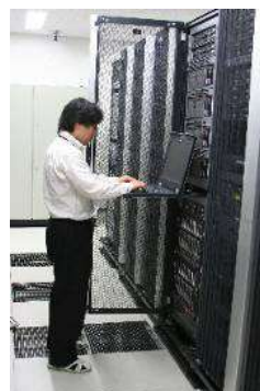
NTTビル内の交換機・ ルータ・サーバ工事、 電力工事
