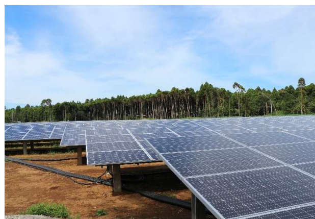
■ メガソーラー工事
