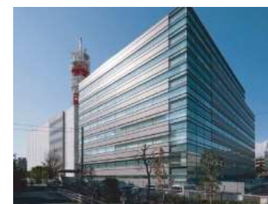
【電気・空調工事】
