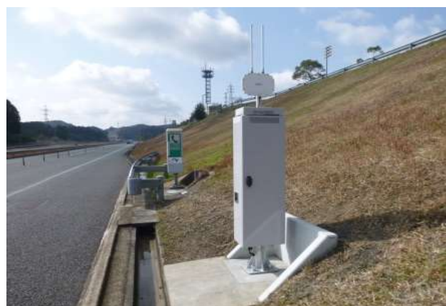
■ 道路通信設備工事
