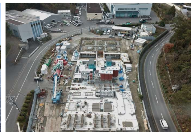
■ 環境プラント工事
