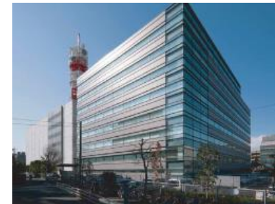
【電気・空調工事】
