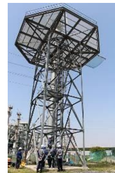
屋外・屋内の無線 基地局工事
