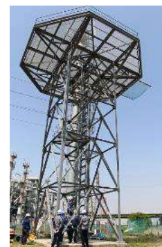
屋外・屋内の無線 基地局工事
