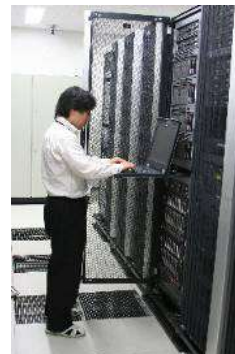
NTTビル内の交換機・ ルータ・サーバ設置工事、 付帯電気・空調工事
