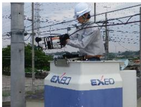
光ファイバ・ケーブル敷設工事、 FTTH工事、通信土木工事
