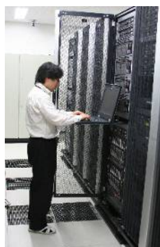
電話局内の交換機・ ルータ・サーバ設置工事、 付帯電気・空調工事
