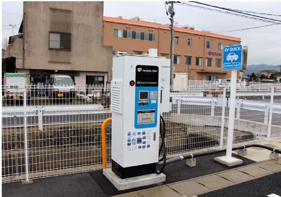
写真は、『マルト SC窪田店』の駐車場に設置した 電気自動車用急速充電器
