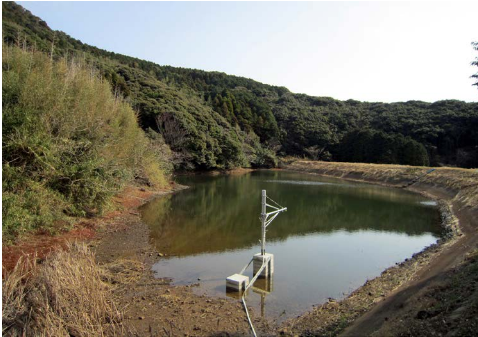
写真は、「永田上ため池」での実証実験の様子 (ため池に手前部分に設置しているのが、水位を計測するセンサー)
