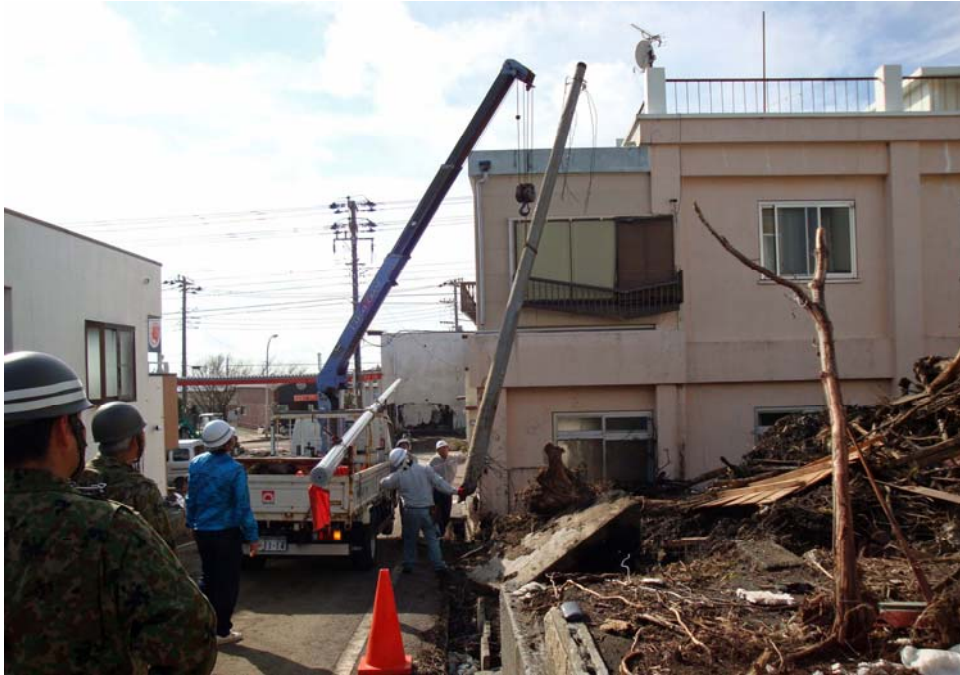
写真は、災害復旧工事の様子(被災設備の撤去作業)
