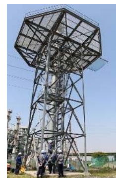
屋外・屋内の携帯電話 基地局工事
