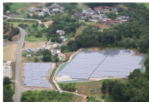
(新府ソーラー発電所)
