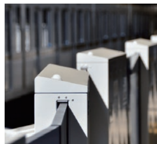
鉄道通信工事
