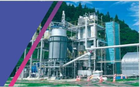
福島県古殿町にてReGaWatt GmbH社のガス化発電設備(KOMBI POWER SYSTEM)を用いた木質バイオマスガス化発電施設の実証試験を行いました。木質バイオマスガス化発電は二酸化炭素を吸収するバイオマス資源を燃料とするため、二酸化炭素削減に貢献、廃棄物の再利用による循環型社会の構築、森林保護のために間伐された木材を燃料として活用することから再生可能エネルギーの一つとして注目されています。
