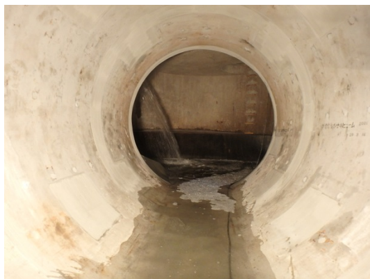
完成後管内【掘進機機外殻残置部】
