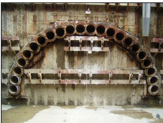
パイプルーフ工施工例
