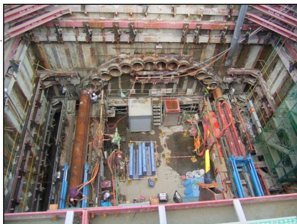
パイプルーフ施工例
