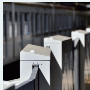
鉄道通信工事
