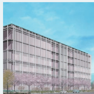
データセンター
