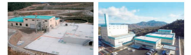
水処理プラント
