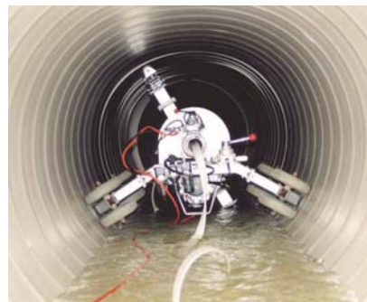
供用中管渠 施工状況
