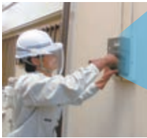
スマートメータ取付工事
