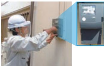
スマートメータ取付工事
