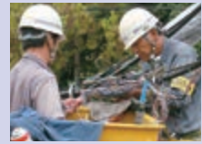
A-XGP工事着工
