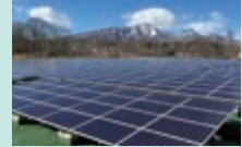
メガソーラー発電所
