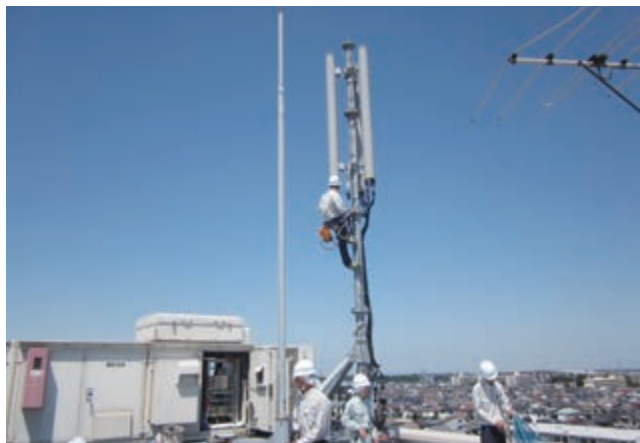
携帯電話基地局の設置工事
