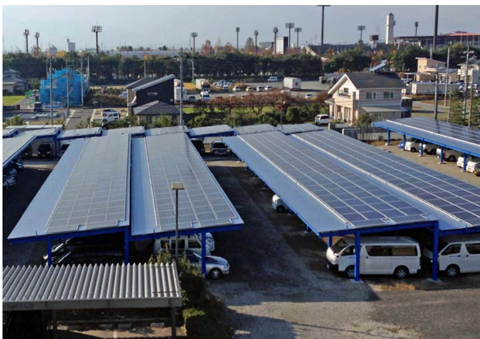
写真は、駐車場の屋根に設置した太陽電池モジュール
