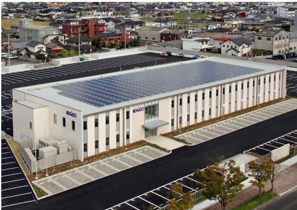
写真は、屋上に設置した太陽電池モジュール
