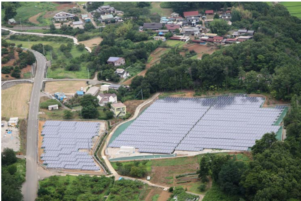
写真は、「新府ソーラー発電所」
