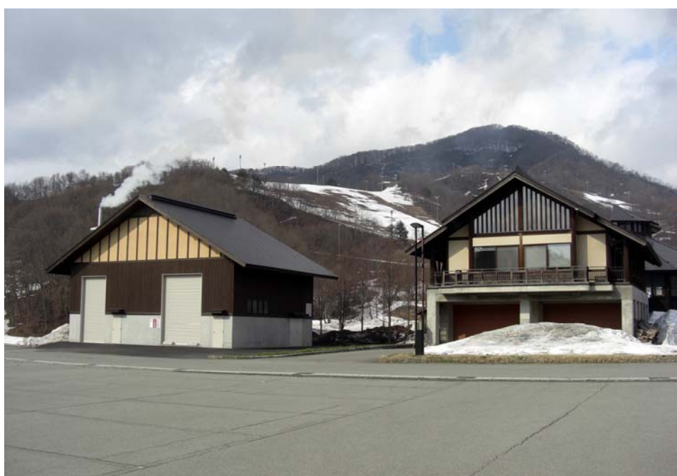
写真は、バイオマスボイラ棟(左)と 回収された熱源を利用する温浴施設「ホットハウスカムロ」(右)
