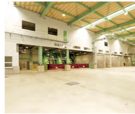
■ プラットホーム/ストックヤード 収集された資源ごみは各貯留ヤードに搬入されます。
