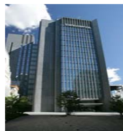
渋谷ガーデンフロント トランスコスモス本社ビル
