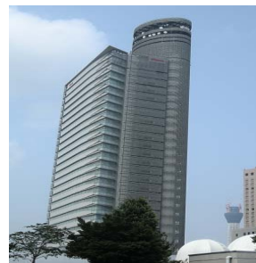
ドコモ墨田ビル (電気設備)
