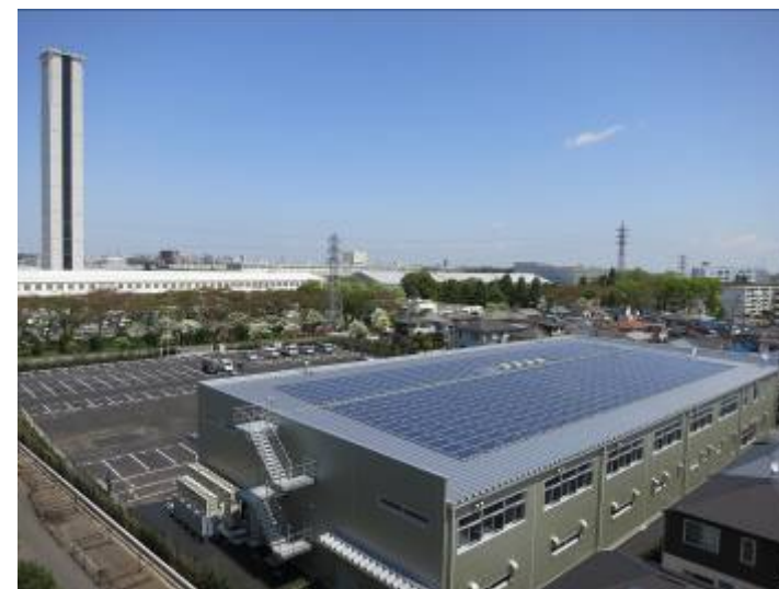
(府中総合技術センタの太陽光発電システム<計100kwの発電能力>)
